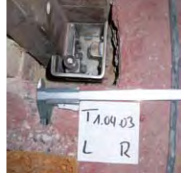
Lagerbolzen eingebaut
